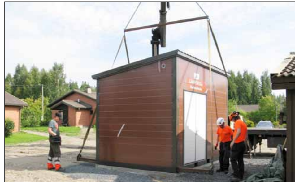
Käyttövalmis kontti nostetaan perustuksilleen.
